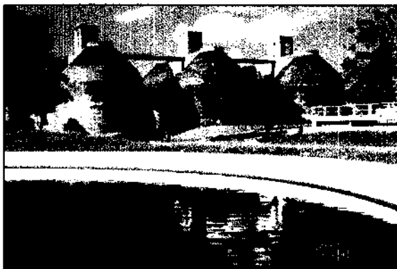
Figura 34 - Decantador Secundário e Digestores
