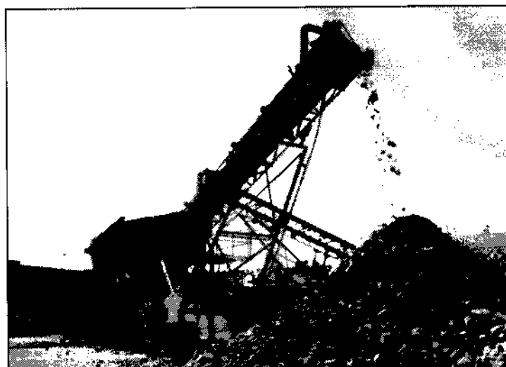
Figura 73 – Usina fixa de RCC.
